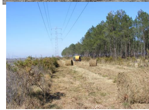
Débroussaillage sous une ligne électrique haute tension
