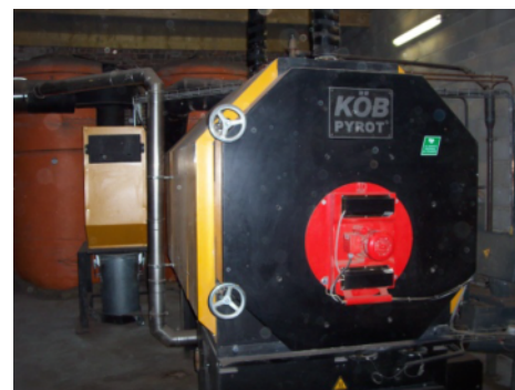
Chaudière biomasse pour les particuliers (50 kW)
